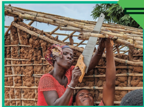
Constructietraining voor de gemeenschappen in Mozambique.
